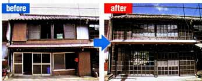
空き家となった古民家はオフィスやスタジオに生まれ変わる
